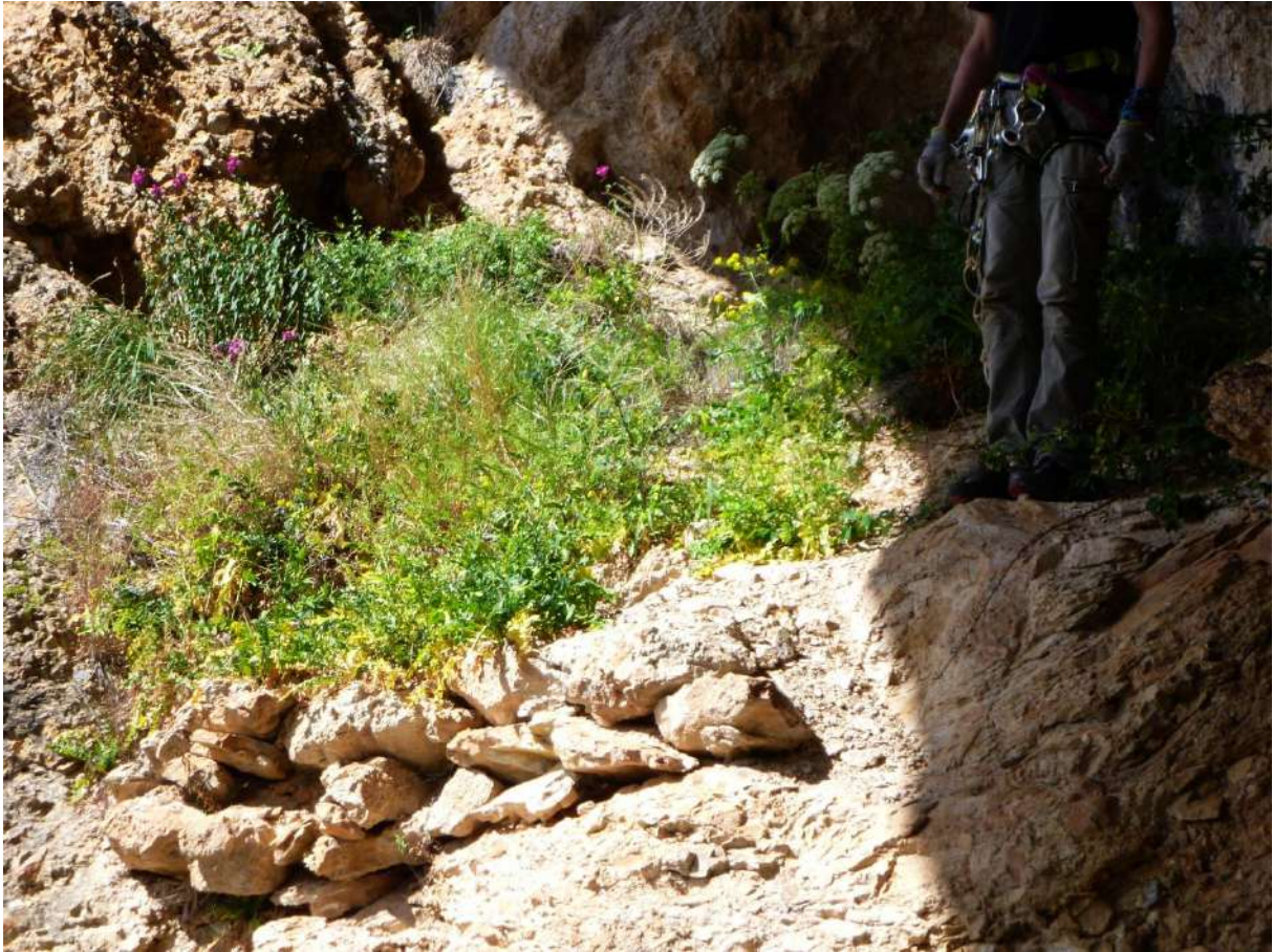
Fig : Mur de la terrasse supérieure.
